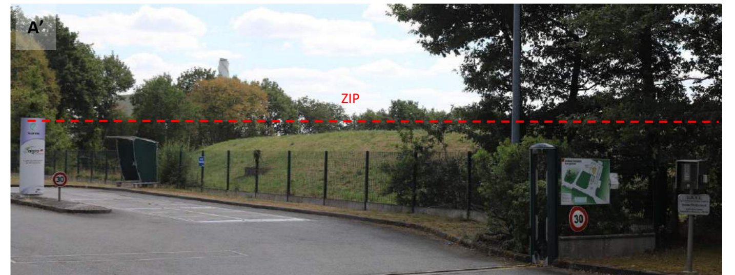
Photo 37 : Au niveau de l'accès nord de l'usine de traitement des déchets, la végétation arborée s'interrompt et laisse apparaître les pentes enherbées du site
